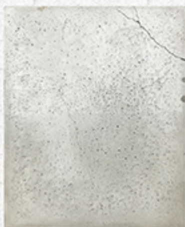
施工例/珪矽 施工後
