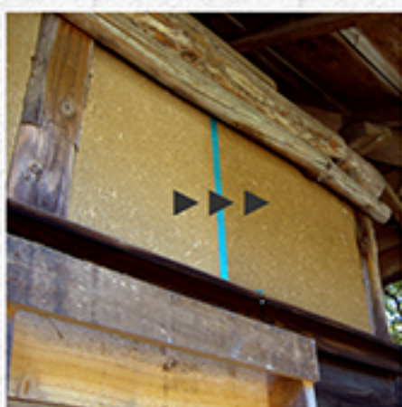
施工例/築60年経過土壁
