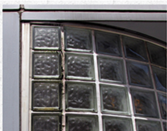
施工例/ガラスブロック 2011年震災により雨漏り
