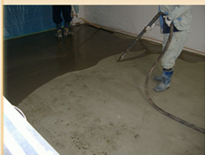
④ SL材施工 →
