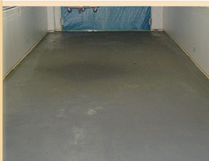
③ P-II施工(ローラーで塗布) →
