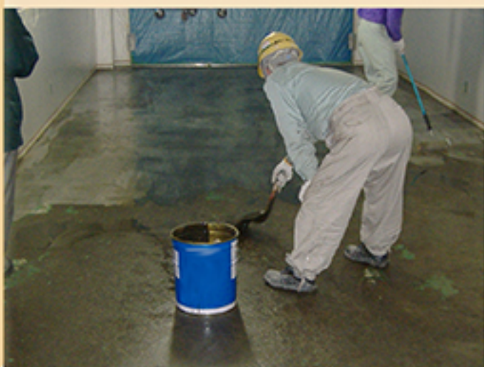
② オイルタック施工(ローラーで塗布) →
